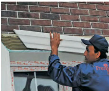
11. Нанесите клеевую смесь на место стыка элемента с несущей поверхностью и нанесите клей-пену на место стыка деталей между собой.
