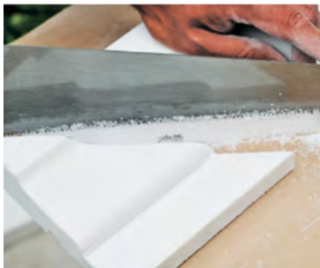
10. Подрежьте элемент до нужного размера и конфигурации.
