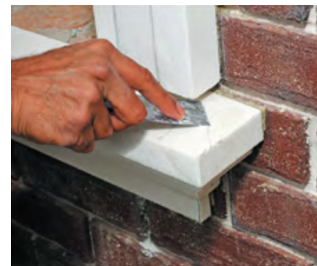
16. Покройте места стыков смесью "DarMix" шпателем на глубину 2-2,5 мм.
