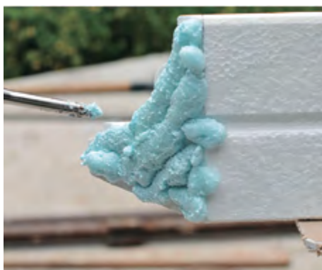
12. Валик клей-пены диаметром 10 мм должен быть нанесен на всю поверхность стыка элемента.
