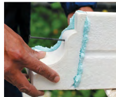
14. При необходимости зафиксируйте элементы между собой с помощью винченного шурупа.
